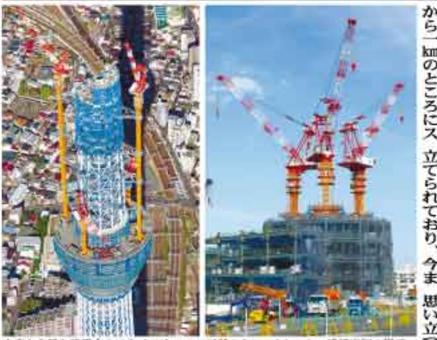
上空から見た建設中のスカイツリー 三基のタワークレーン。建設当初の様子
