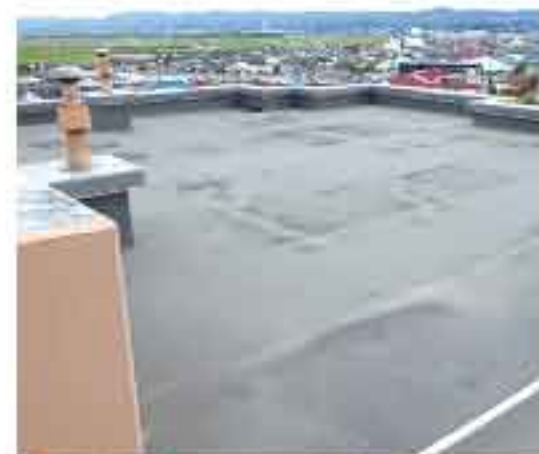
来期に補修を検討している屋上防水
