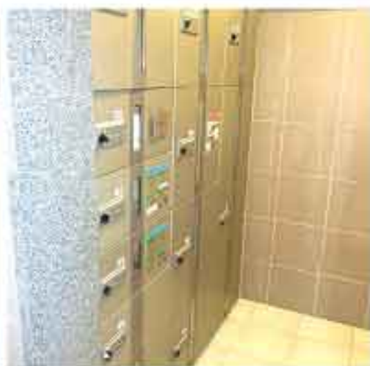
宅配ボックス
