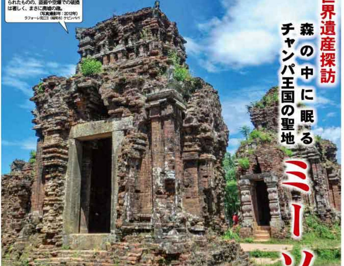
モルタルなどの接着剤を一切使わずに、焼成レンガを積み上げて造られている
