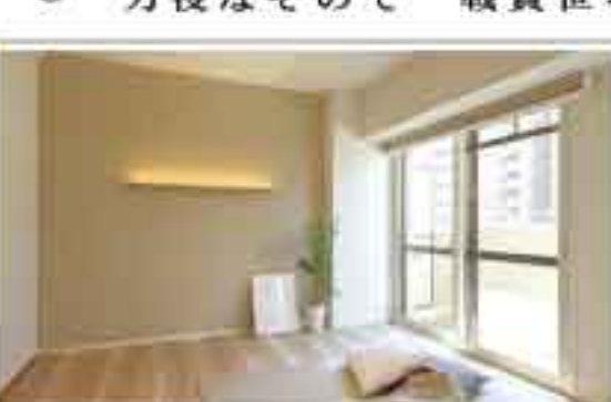
リノベーションモデルルーム「M・Reno橋本町」。アルミサッシ+1枚ガラスの内側に樹脂サッシ+ペアガラスの内窓を設置
