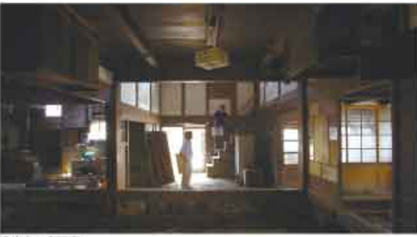
改修中の古民家
