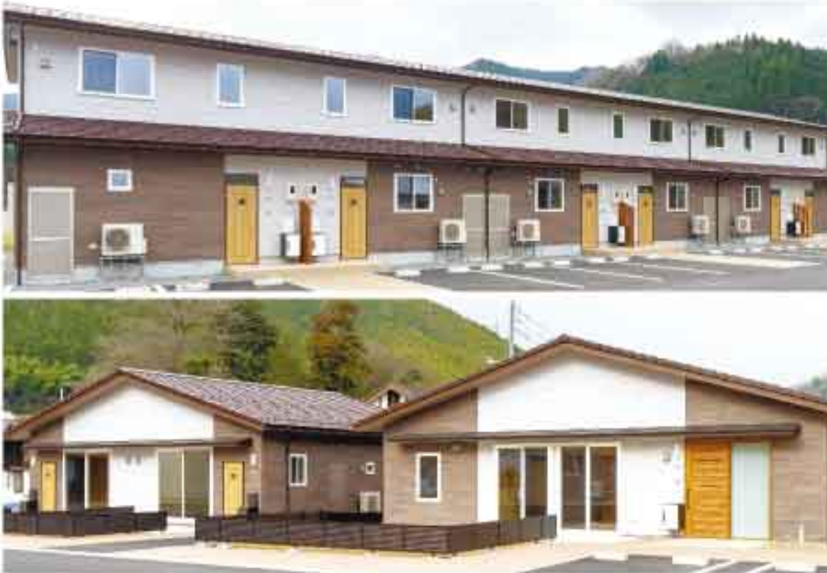
【鳥取県江府町】官民連携で整備した賃貸住宅「佐川第2団地」。写真上は3LDKのファミリー向け、写真下は3LDKの車いす対応の戸建て住宅(右)と1LDKの単身者用の集合住宅(左)
