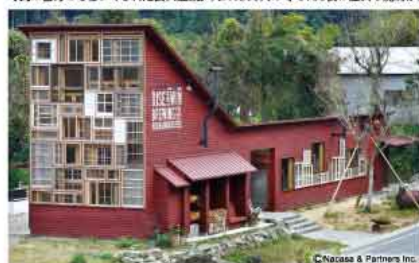
RISE &amp; WIN外観。坂下の町から見えるように高さ8mとした
