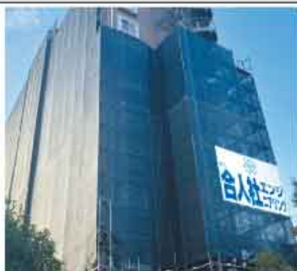
大規模修繕工事中
