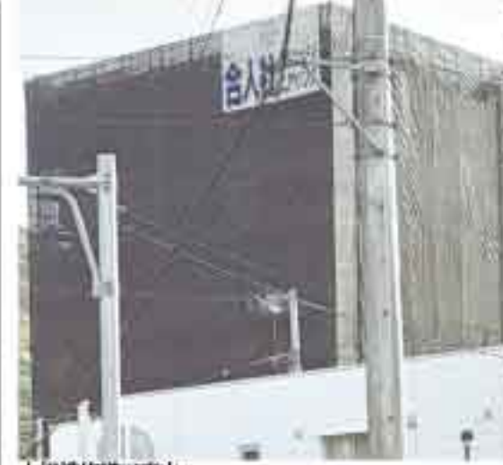
大規模修繕工事中
