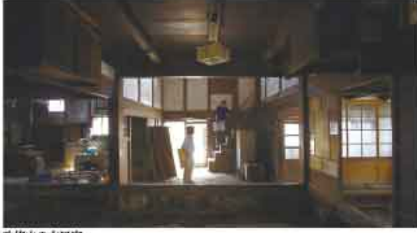
改修中の古民家
