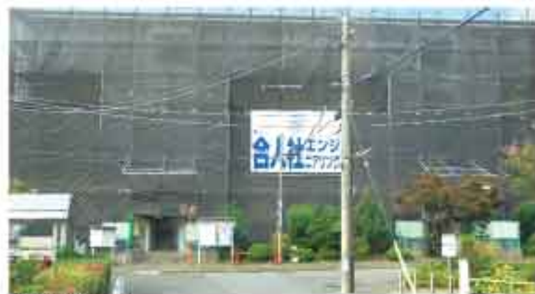
大規模修繕工事中
