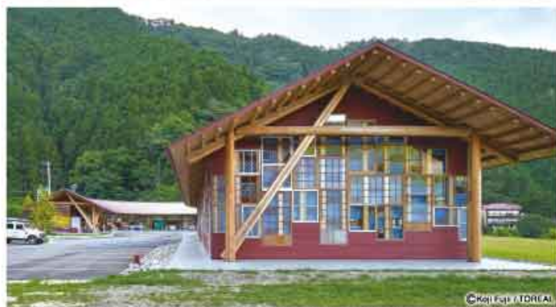
町民の協力のもとつくられた公共建築。人口1500人の町で700枚の建具や廃材が集まった
