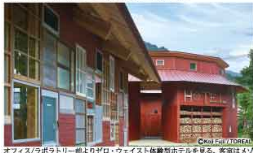
オフィス/ラボラトリー前よりゼロ・ウェイスト体験型ホテルを見る。客室はメゾネット形式の4室が円環上に配置されている
