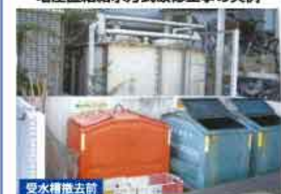
受水槽撤去前
