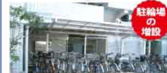
受水槽撤去後
