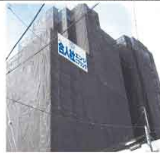
大規模修繕工事中
