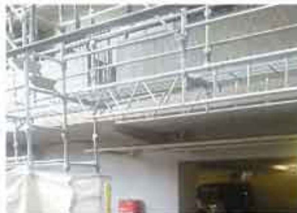
大規模修繕工事中のマンション
