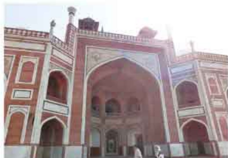
▲西ファサード (正面) 赤砂岩を削って白大理石をはめ込んでいるため、色彩が劣化せず赤と白の美しいコントラストを保っている
