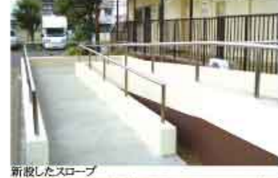
新設したスロープ
