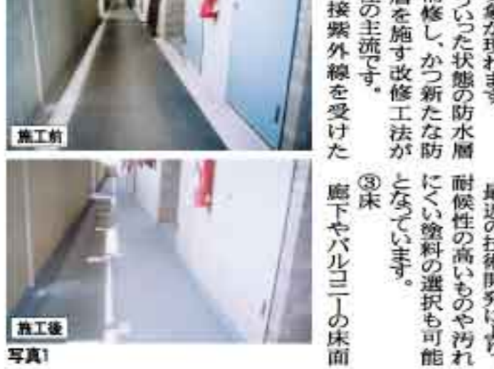
施工前 施工後
